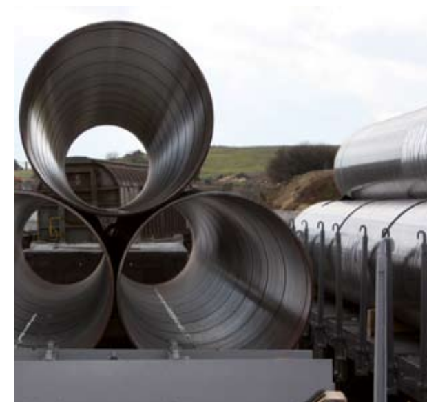
Mächtige Stahlrohre für den Bau der Pipeline „Gazelle“. Foto: DB Schenker
